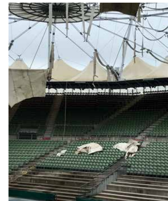
Derzeit wird die innere Membran des Daches saniert Fotos: Mirco Westphal
